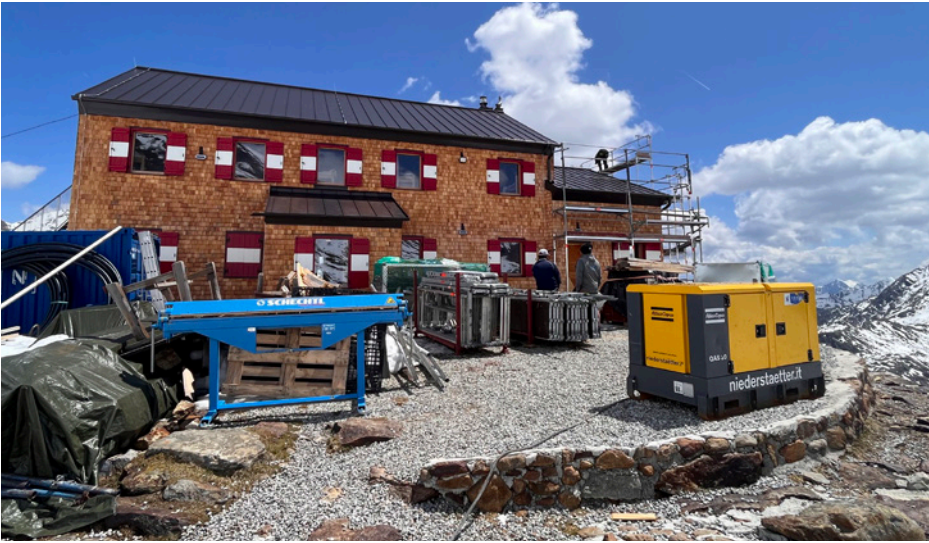
Bauarbeiten auf einer Höhe von 2.586 Metern sind herausfordernd, schweißen das Team aber zusammen
