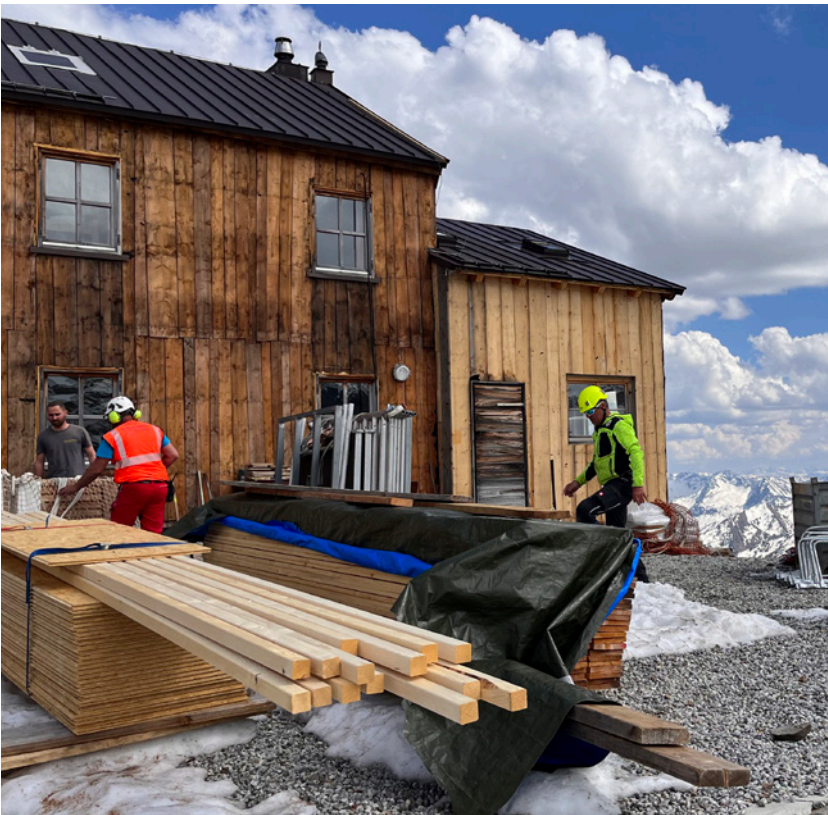
Die Teplitzer Hütte setzte bei der Sanierung auf Nachhaltigkeit
